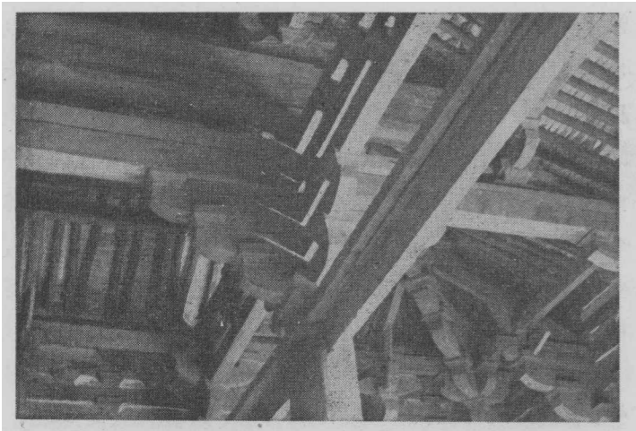
圖 5 (太谷 萬安寺) 斗拱在內部承托梁架枋椽
